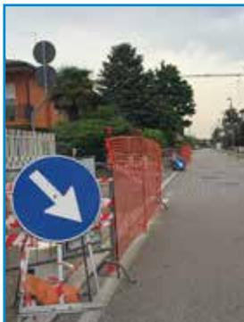
Ci sono stati la sistemazione e il ripristino dei tratti più ammalorati delle cordone di separazione tra pista ciclabile e corsia stradale, con in prospettiva l'installazione anche dei dissuasori metallici di delimitazione viaria al fine di garantire la viabilità ciclopedonale libera da auto che troppo spesso vengono parcheggiate lungo la pista ciclabile.
